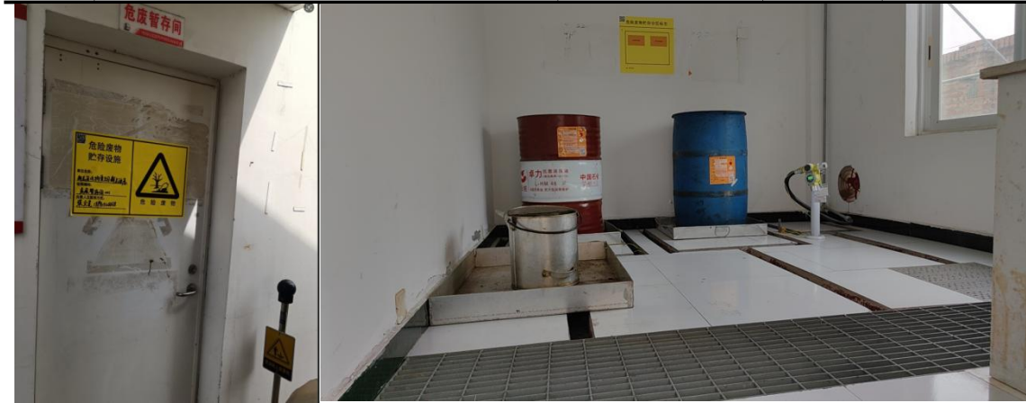
图 2-18 危废暂存间照片
