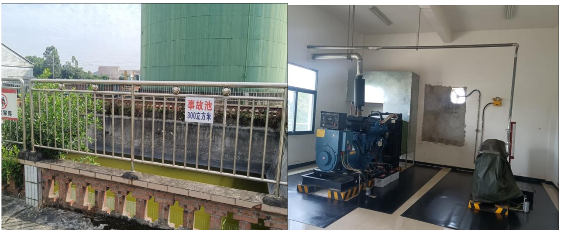
图 2-22 事故应急池照片和发电间照片
