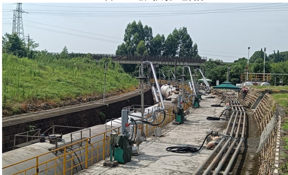
图 2-15 顶部卸油鹤管（上部卸油）
